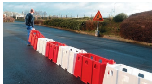
Pas : 1.20m soit 833 séparateurs par kilomètre
