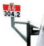
Sur pieu de glissière
