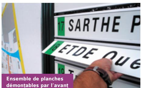
Ensemble de planches démontables par l'avant
